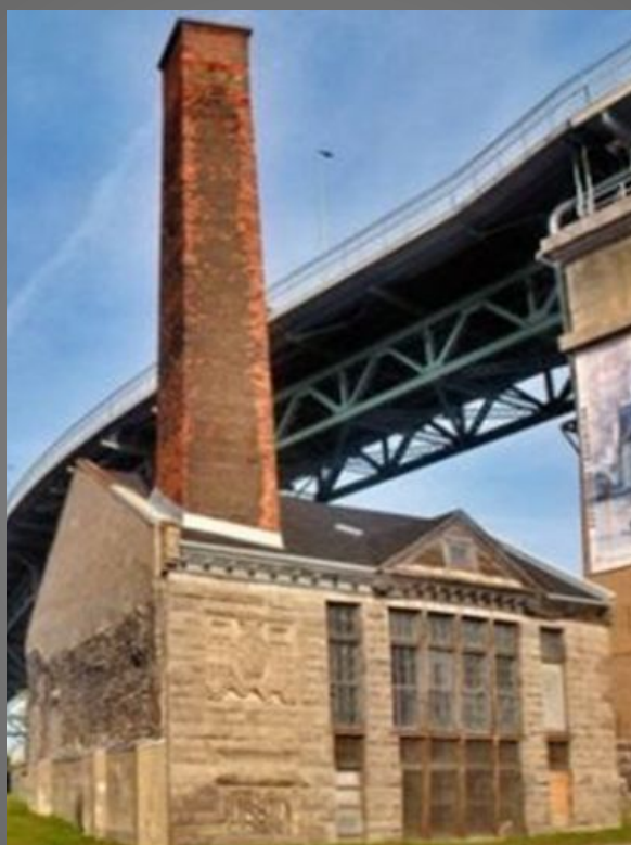
Ancienne station de pompage Craig Source : Ville de Montréal
