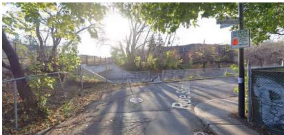
Vue sur le viaduc Sainte-Marguerite depuis Saint-Philippe
